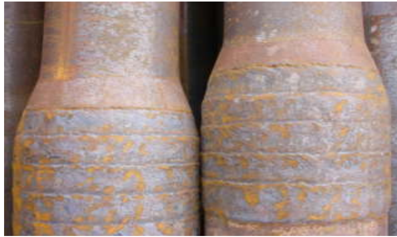
位于 18° 斜坡焊道底部的咬边
